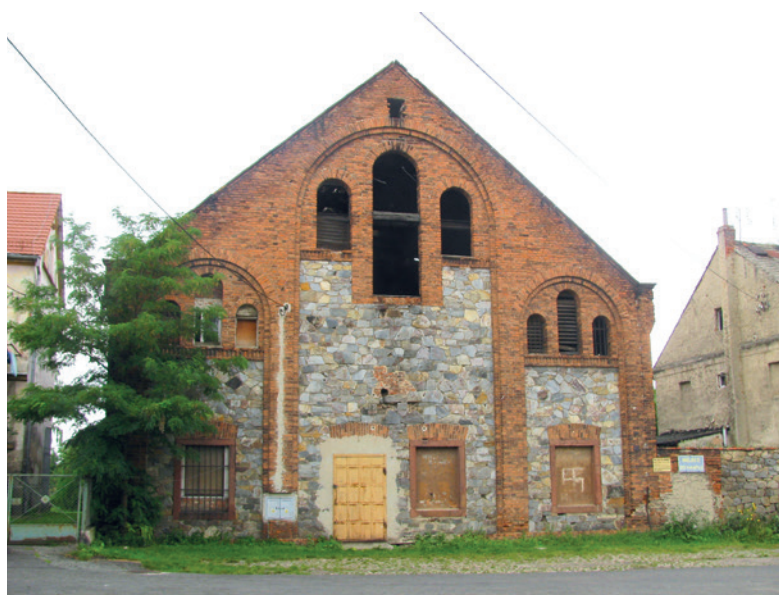
Fot. 151. Kamienno-ceglany spichlerz z XIX (XVIII?) wieku przy placu Szkolnym w Borku Strzelińskim.
