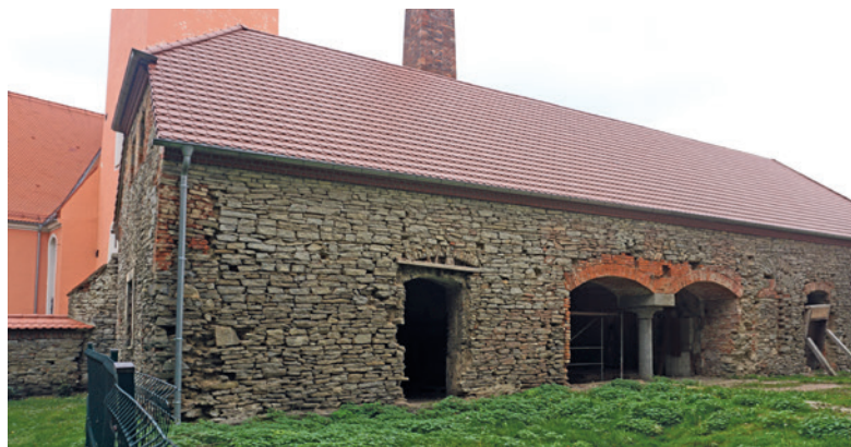
Fot. 137A, B. Dwór z 1550 roku w Borku Strzelińskim (2022 rok). U góry fasada od strony kościoła, u dołu fasada od strony pałacu.
