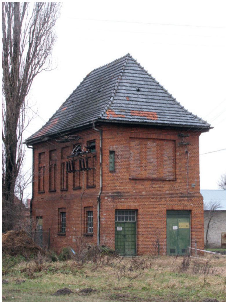
Fot. 152. Ceglany transformator z początku XX wieku przy ulicy Strzelińskiej w Borku Strzelińskim.
